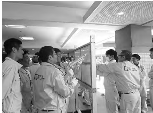
シーリング材充填
