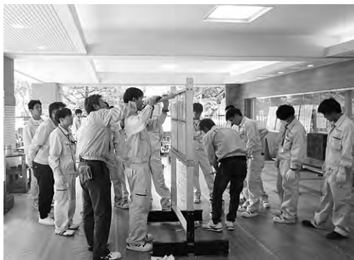
シーリング材充填
